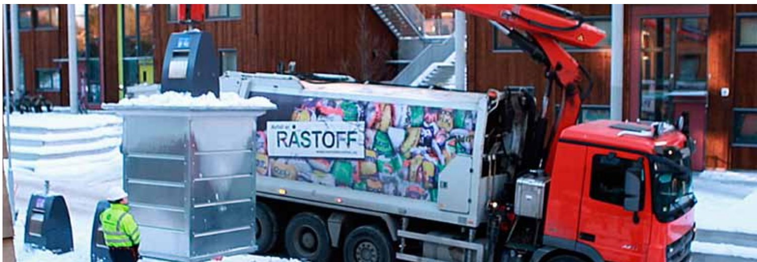
Containeren plasseres under bakkenivå.
